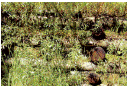
Foto 1 – Consolidamento realizzato con palificata doppia in legname e talee di salice (foto ALESSANDRO TRIGILA).
